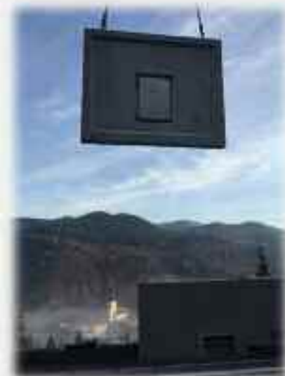
Hoch über der Baustelle schweben die Teile zum vorgesehenen Platz und werden millimetergenau eingesetzt.
