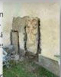
der Altar mit Gerüst
